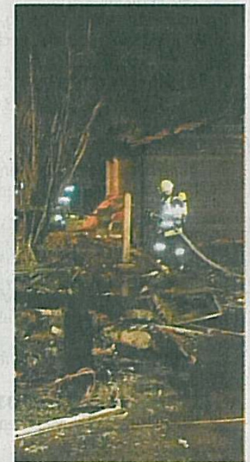
Kontrolle der qualmenden Trümmer.
